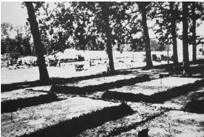
14 Die frisch aufgeworfenen Gemeinschaftsgräber während der Bauarbeiten
